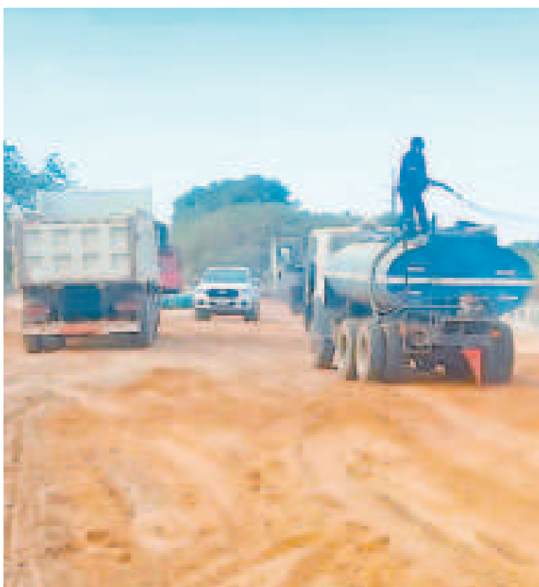
Trabajos en la Doble Vía Santa Cruz-Warnes.
