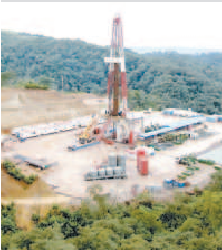
El área de intervención del pozo Bermejo -X46.
