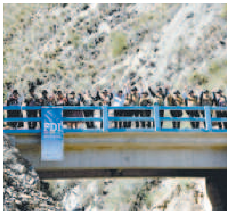
Uno de los puentes vehiculares entregados en Palca.
